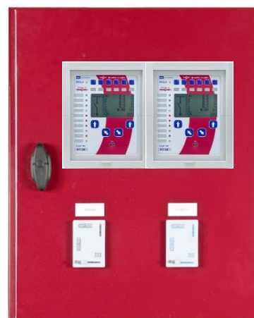
Solution en coffret pour Reconfigurateur SIRACUS avec des relais GBI30
