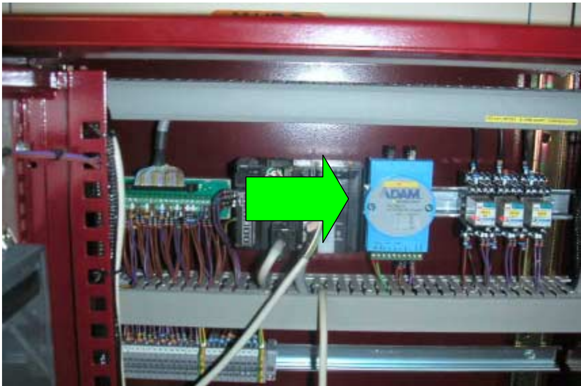
Convertisseur RS485/Fibre optique du Gestionnaire de Boucle
