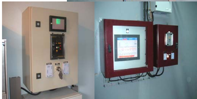
Coffrets de découplage: différentes présentations
