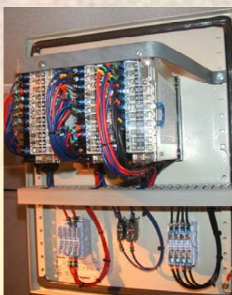
Vue du câblage des relais et des automatismes d'un coffret GTE1.3 et de la barre de calage pour le transport
