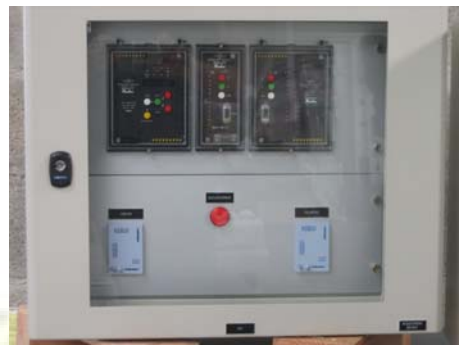
Coffret de découplage GTE 1.4/RE prévu pour le recouplage automatique au réseau public de la centrale de production
