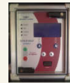
Relais PWH pour poste NCF13-100
