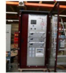
Armoires de travée HTB
