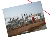
Des interventions sur site
